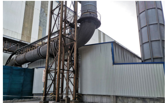
鑄坯綫除塵系統
